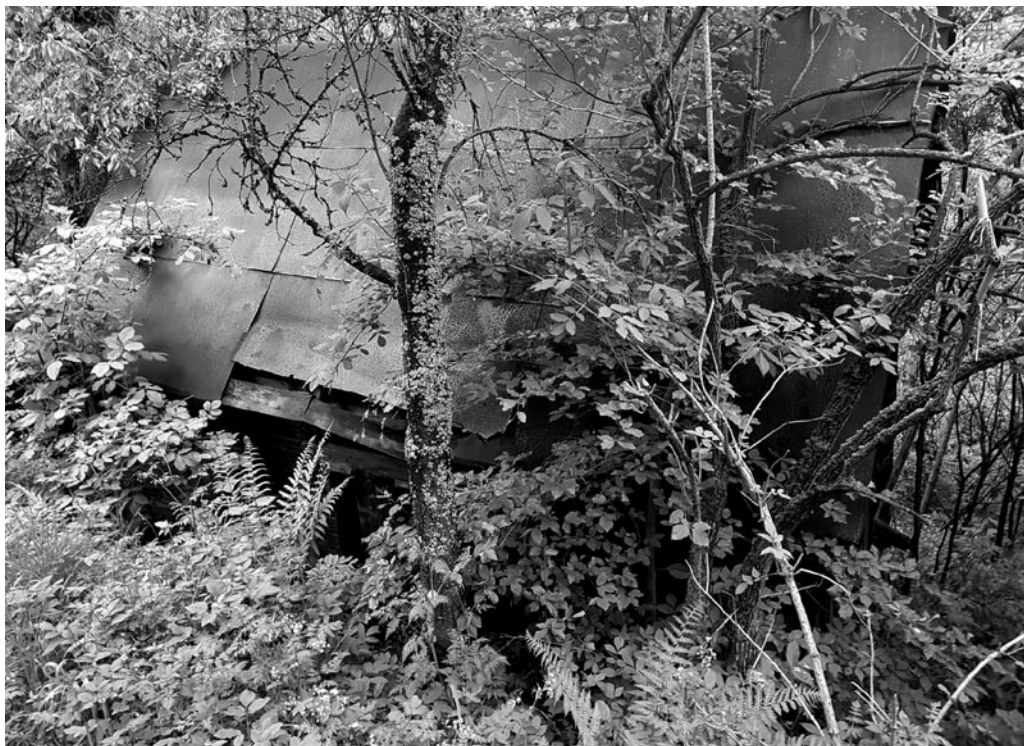
Obr. 6: Sušárna usedlosti v Kršelkách (k. ú. Halenkov, p. č. 6407), náleзовá situace podzim 2019. (Foto: Zdeněk Bill) |
