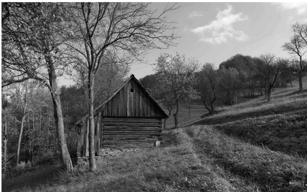
Obr. 3: Vzhledem k nebezpečí, které představuje otevřený oheň pro ostatní obytné a zemědělské stavby (na Horním Vsacku s masivním zastoupením staveb dřevěných), se ustálil zvyk situovat je v bezpečné vzdálenosti od samotné usedlosti. (Foto: D. Halata)
