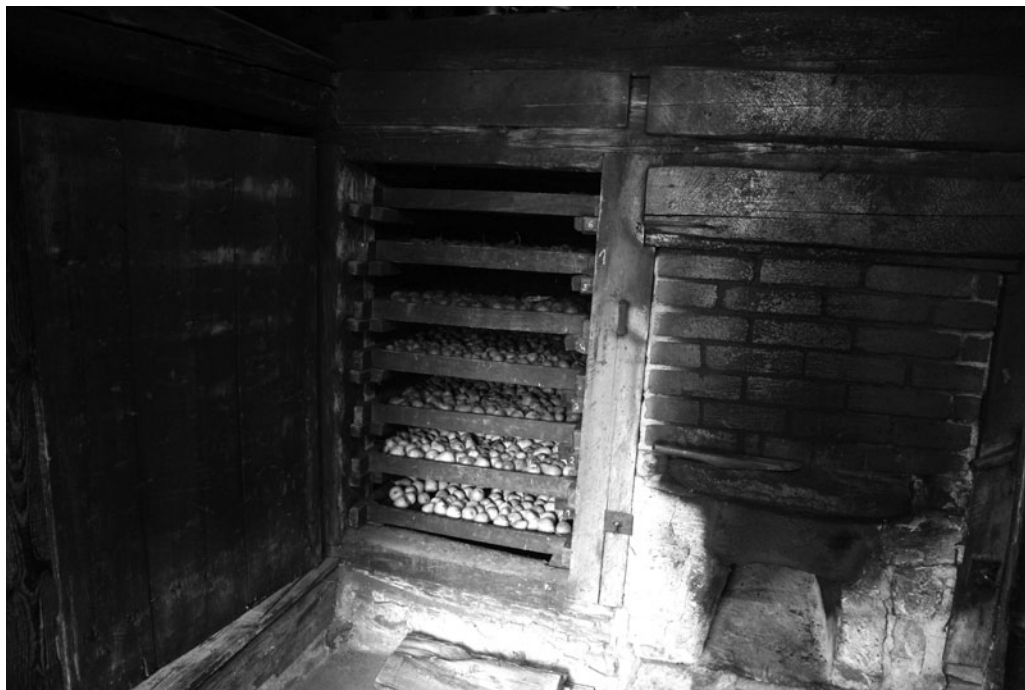
Obr. 9: Interiér dvojprostorové sušárny ovoce na pasekách u Hrbáčků, Huslenky – Uherská (k. ú. Huslenky, p. č. 4012/4). Sušárna je dokladem archaického stavebního řešení, s obsluhou topeniště z prostoru přebíračky, se dvěma bočními dvířky do teplice. (Foto: autorka)
