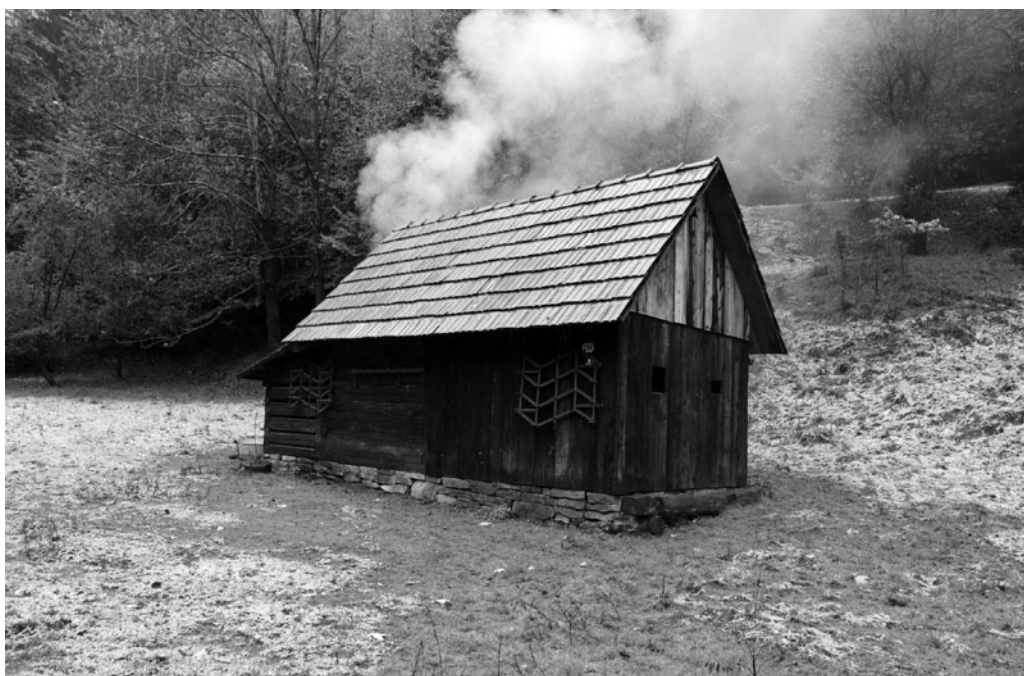
Obr. 10: Tříprostorová sušárna ovoce z 90. let 19. století. Původně z údolí Zbeličné při čp. 328 (k. ú. Huslenky), v roce 2016 transfer do údolí Lušová (Halenkov), znovuzprovozněná na podzim 2017 při čp. 351 (k. ú. Halenkov, p. č. 4165/1). (Foto: J. Koňarič)
