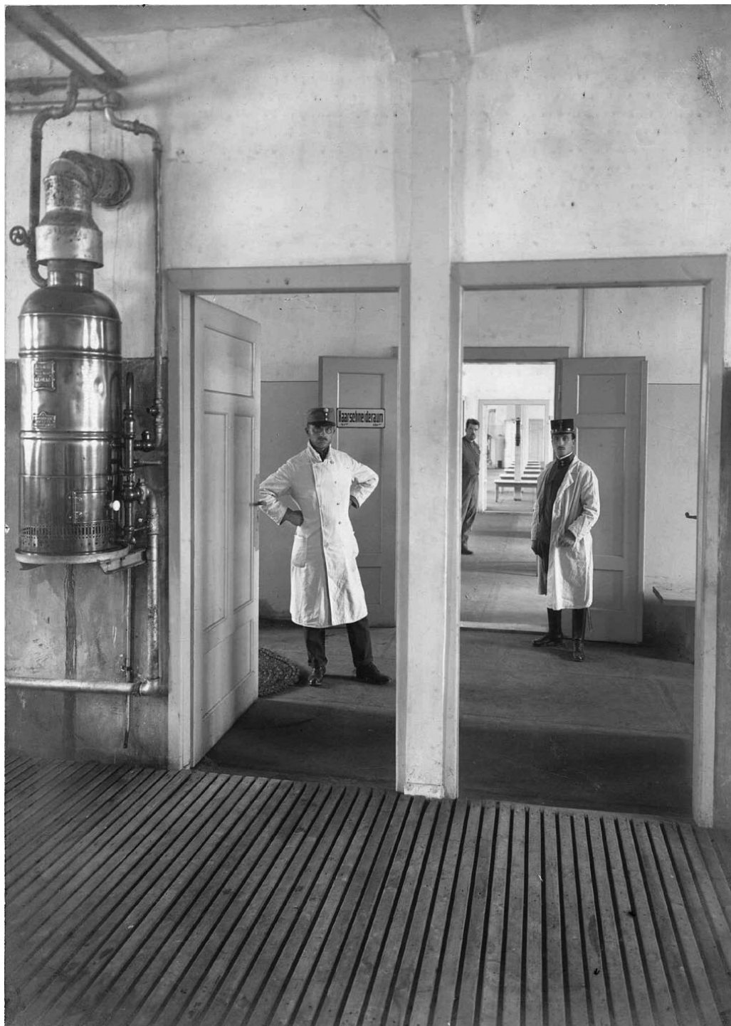
Obr. 4: Kroměříž. Fotografie z roku 1916. Detailní záběr c. a k. vojenské nemocnice (Palackého škola). MZA v Brně – SokA Kroměříž, fond D-4 – Sběrka fotografií a negativů (neinv.).
