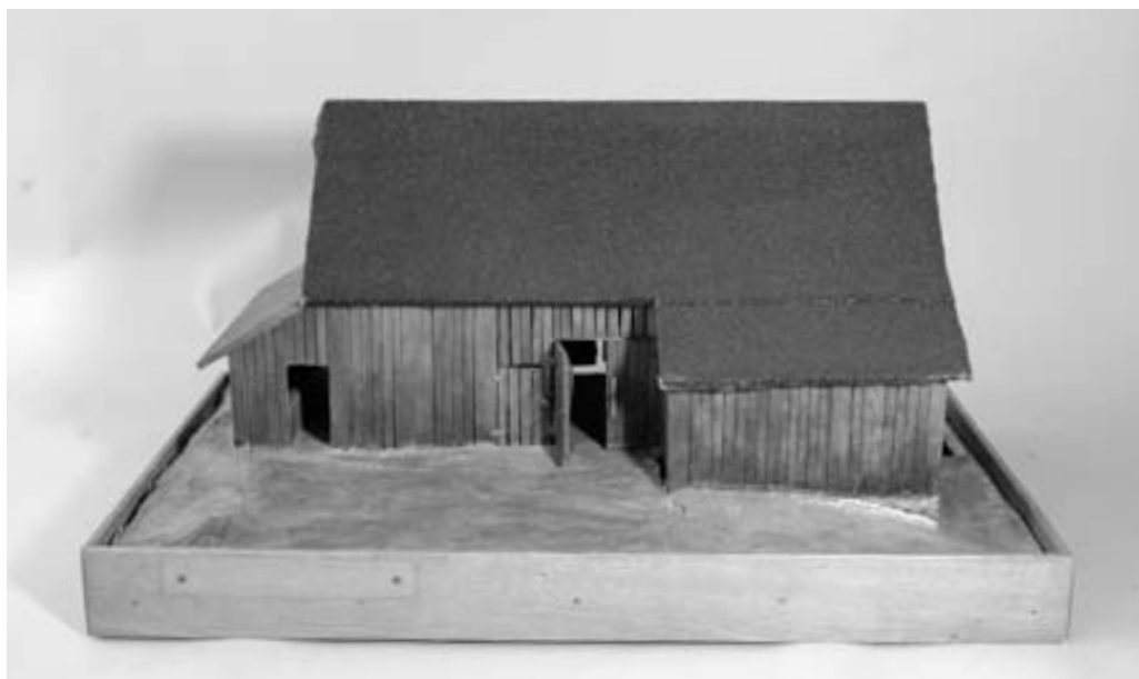
Obr. 4: Model příčně průřezné stodoly s kamennou podezdívkou a deštěnými stěnami. V boční stěně vchod do sklepa. Vrata lafová zavěšená na kožených poučkách. Sedlová střecha kryta šindelem a térovým papírem, na přístavcích střecha pulťová. Budova je umístěna na obdélníkové podložce - sádrou vyplněném dřevěném rámu. Inv. č. E 20179. Foto Gabriela Skyva Dobešová, fotoarchiv MJVM.
