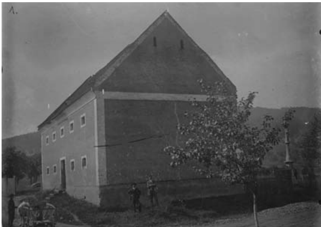
Obr. 11: Kontribučenská sýpka ve Zlíně v roce 1903. Napravo kříž z Langovy dílny. Zapůjčil MZA Brno, SOkA Zlín. |
